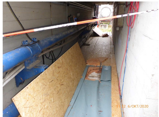
Bild 3: Beispiel einer der beiden Unterführungen der Brücke während der laufenden elektrochemischen Chloridextraktion
